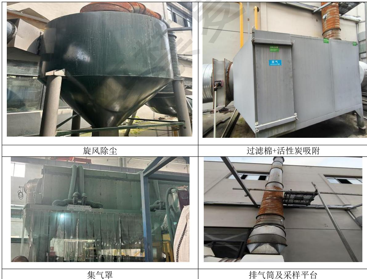
图 3-2 废气处理设施、排气筒现场图
